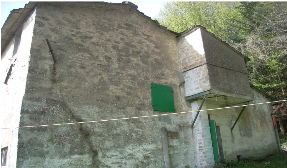
Vista laterale fabbricato principale
