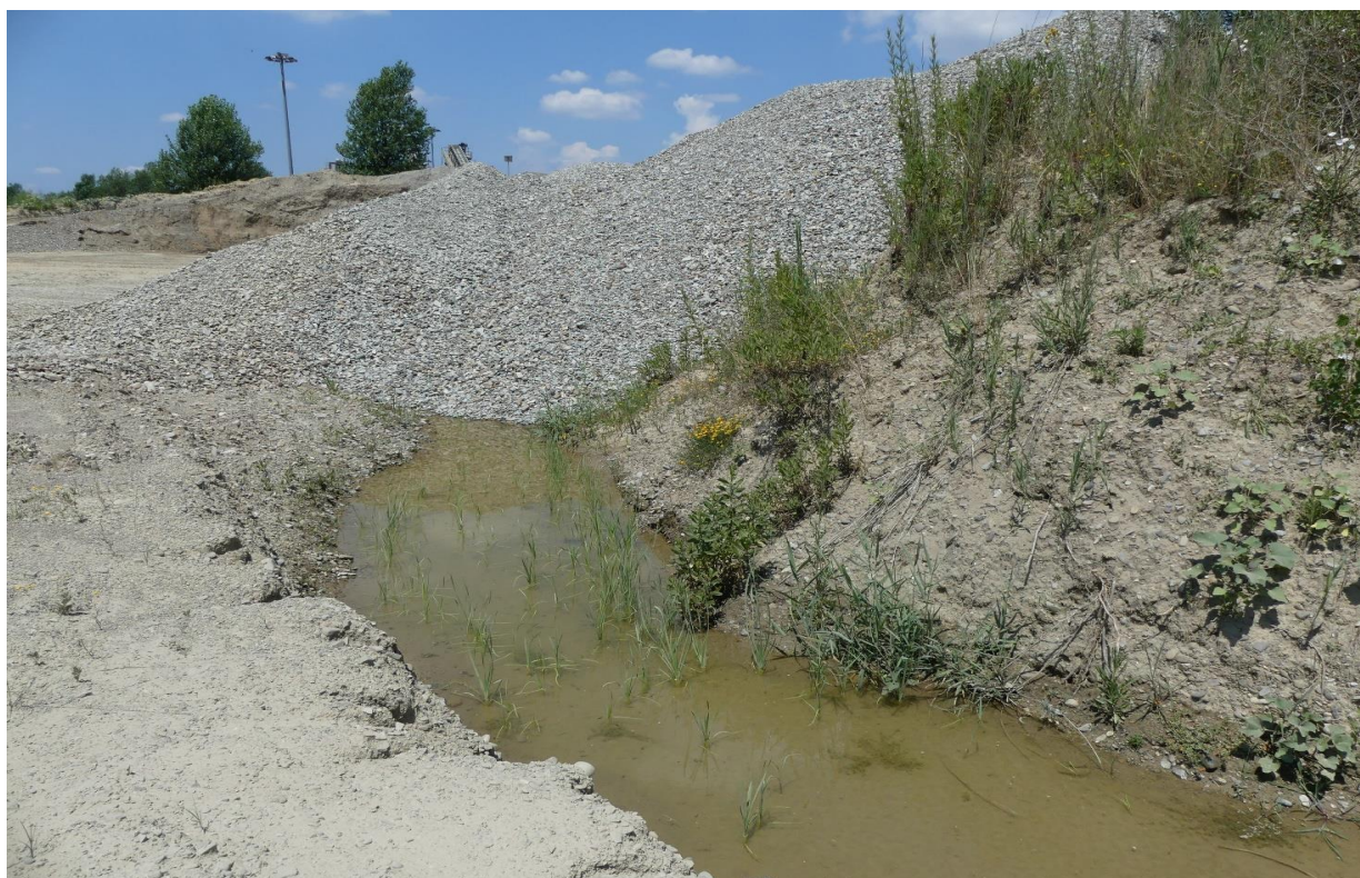
Figura 21 - Zona dei Renai di Signa, cantieri di escavazione degli inerti: in situazioni simili a quella mostrata non di rado molte specie di Anfibi possono tentare la riproduzione (per gentile concessione dell'Archivio WWF – Foto C. Scoccianti – Anno 2019)
