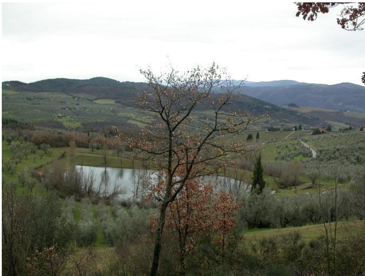
Figura 9 - Lago collinare di Doccia (Pontassieve): si tratta di un bacino artificiale realizzato mediante diga in terra a sbarramento del fosso presente nella piccola vallecola
