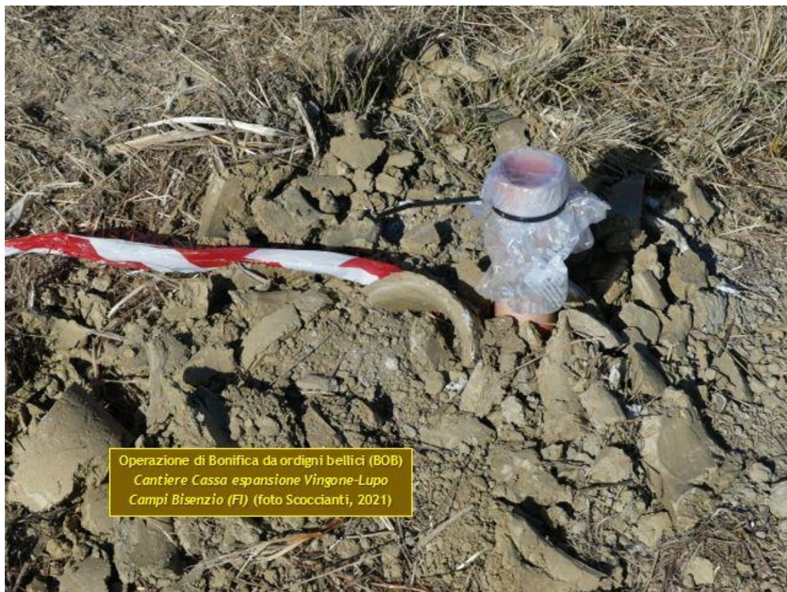
Figura 25 – Chiusura dei fori di trivellazione subito dopo l'esecuzione del sondaggio di ricerca degli ordigni bellici (BOB) e mantenimento, in accordo con l'apposito reparto dell'Esercito, di un numero adeguato di fori (incamiciati con tubi pvc muniti di tappo), per permettere il controllo finale (collaudo) da parte dello stesso reparto dell'Esercito. Cantiere Cassa espansione Vingone-Lupo, Campi Bisenzio (FI) (Foto C. Scoccianti – Anno 2021)
