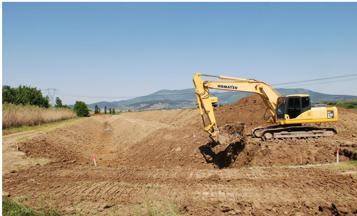
Figura 20 - Il nuovo tratto del canale Garille all'interno dell'Oasi WWF Stagni di Focognano. Il canale, precedentemente caratterizzato da fondo e pareti verticali in cemento (si veda Fig. 8), è stato completamente rinaturalizzato nel 2011 (Progetto: WWF – Comune di Campi Bisenzio – Consorzio di Bonifica) per evitare ogni possibilità di caduta e morte delle specie durante il passaggio da una sponda all'altra. (per gentile concessione dell'Archivio WWF Toscana – Foto C. Scoccianti – Anno 2011)
