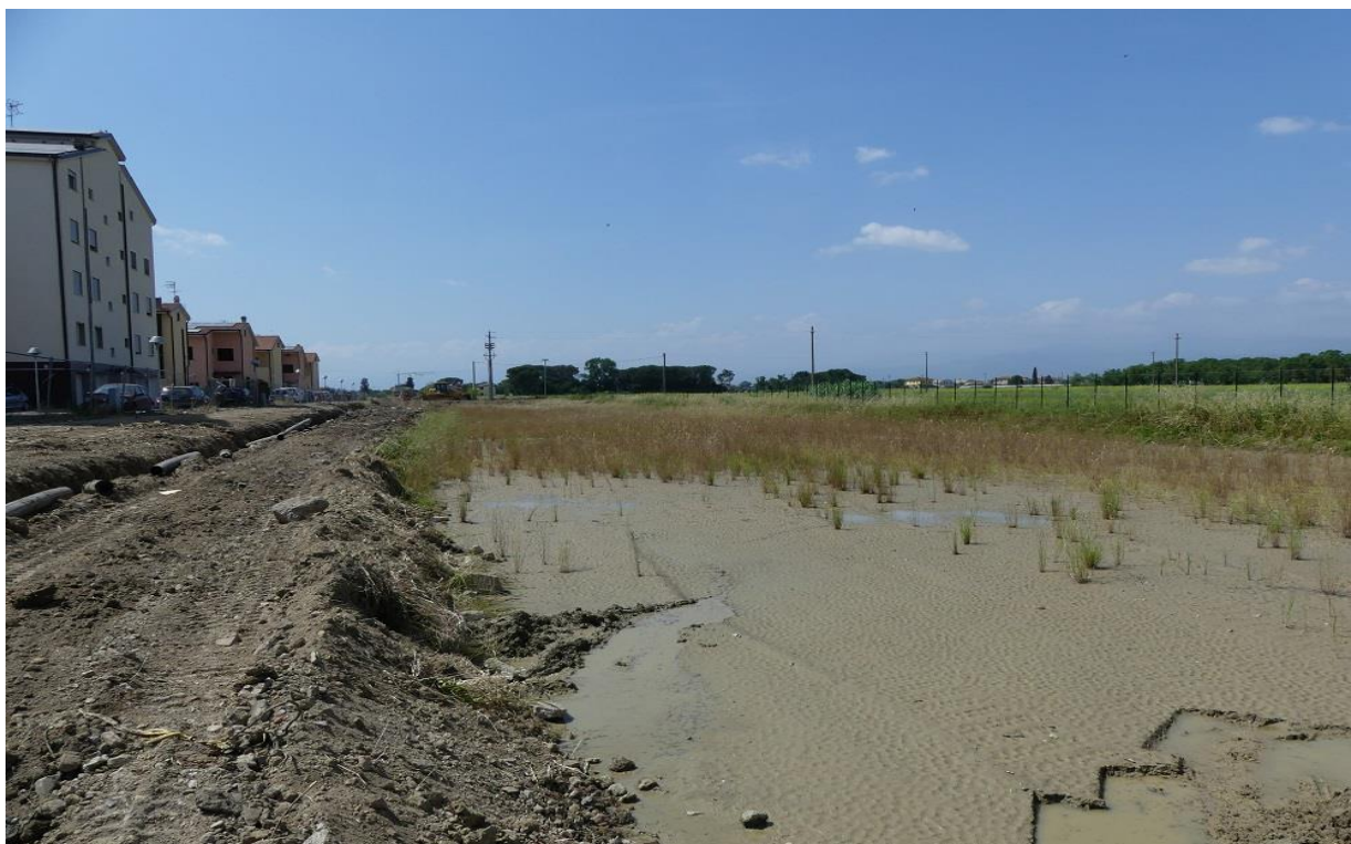
Figura 22 - Zona La Madonnina (Campi Bisenzio) – Un altro esempio di area di cantiere dove erano andati a riprodursi gli Anfibi e da dove sono stati tratti in salvo centinaia e centinaia di individui di varie specie dalle squadre di volontari del WWF (per gentile concessione dell'Archivio WWF – Foto C. Scoccianti – Anno 2019)
