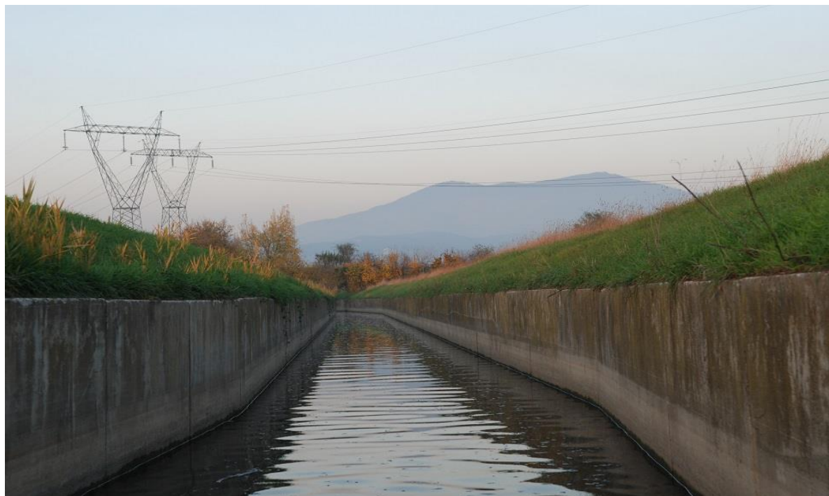
Figura 8 - Esempio di un tratto di canale con pareti verticali. Si tratta del canale Garille al centro della Piana Fiorentina. Strutture come queste sono causa ogni anno della caduta e della conseguente morte di decine e decine di individui di varie specie faunistiche. Come è possibile vedere nella Figura 20, il lungo tratto di questo canale che passava all'interno dell'Oasi WWF Stagni di Focognano è stato completamente rinaturalizzato nel 2011 (Progetto: WWF – Comune di Campi Bisenzio – Consorzio di Bonifica) proprio per evitare ogni impatto sulle specie (Archivio WWF per la Toscana – Foto C. Scoccianti – Anno 2010)
