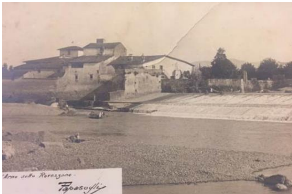
Figura 2.24 - Stesso punto di vista della pescaia in località Rovezzano (Firenze), in una cartolina illustrata in b/n della collezione R.Benvenuti, datata intorno alla fine degli anni '50. Le strutture a corredo delle pescaie sono ancora presenti.
