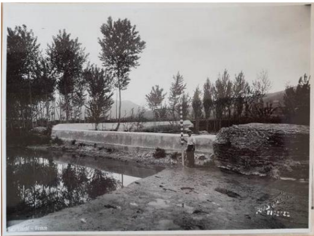
Figura 2.33 - Fotografie dei lavori di ricostruzione dell'argine della briglia conservata presso gli uffici del Genio Civile di Firenze datata 1937. Evidente in primo piano il toro in pietra in sponda sinistra ancora presente
