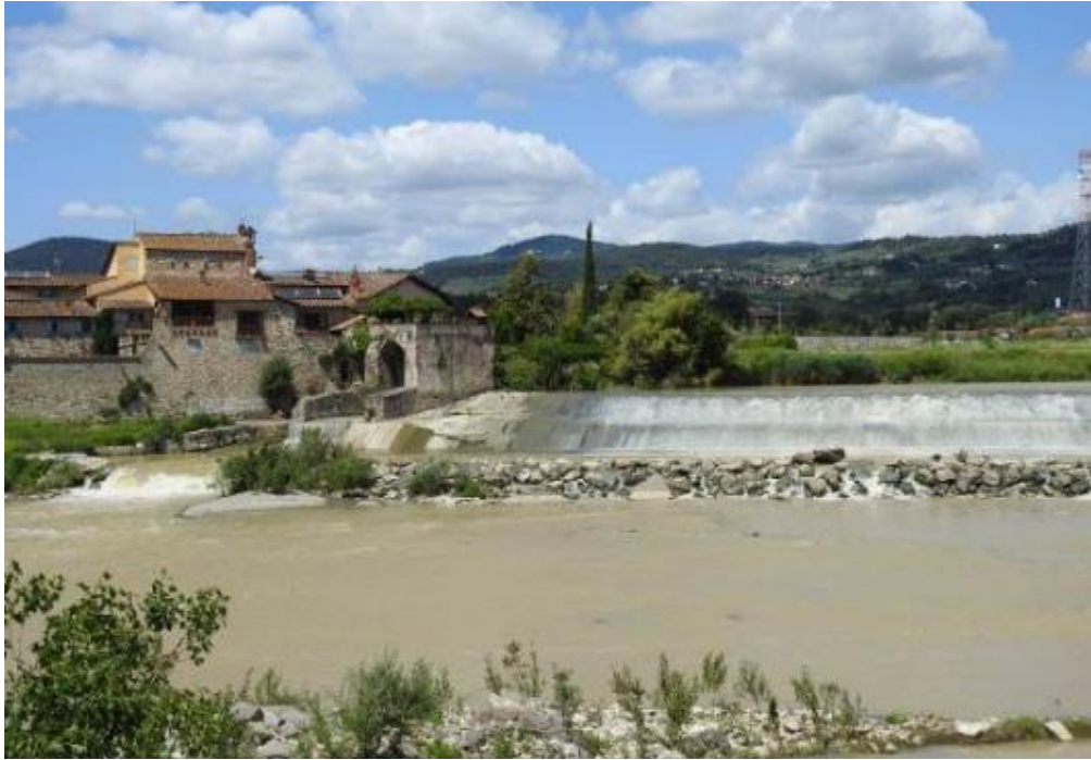
Figura 2.23 - Pescaia in località Rovezzano (Firenze)
