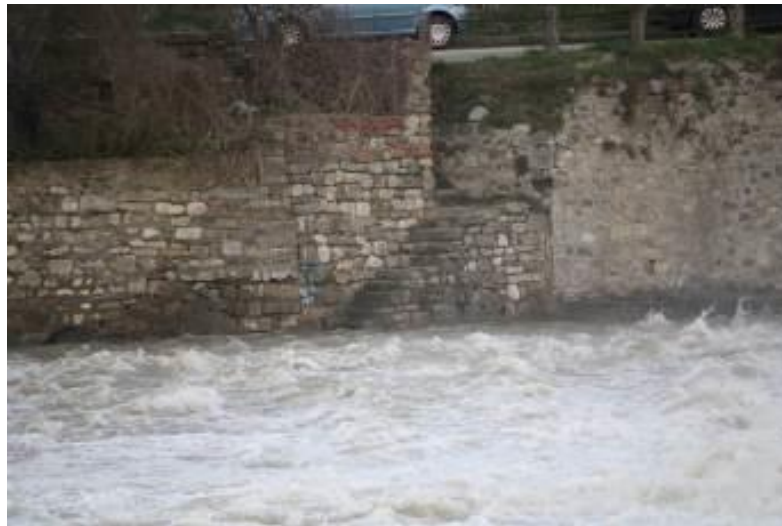
Figura 2.14 - Pescaia in San Francesco (Pelago), località La Docciola e particolare del muro in destra idraulica del fiume Sieve realizzato in bozze squadrate di pietra locale
