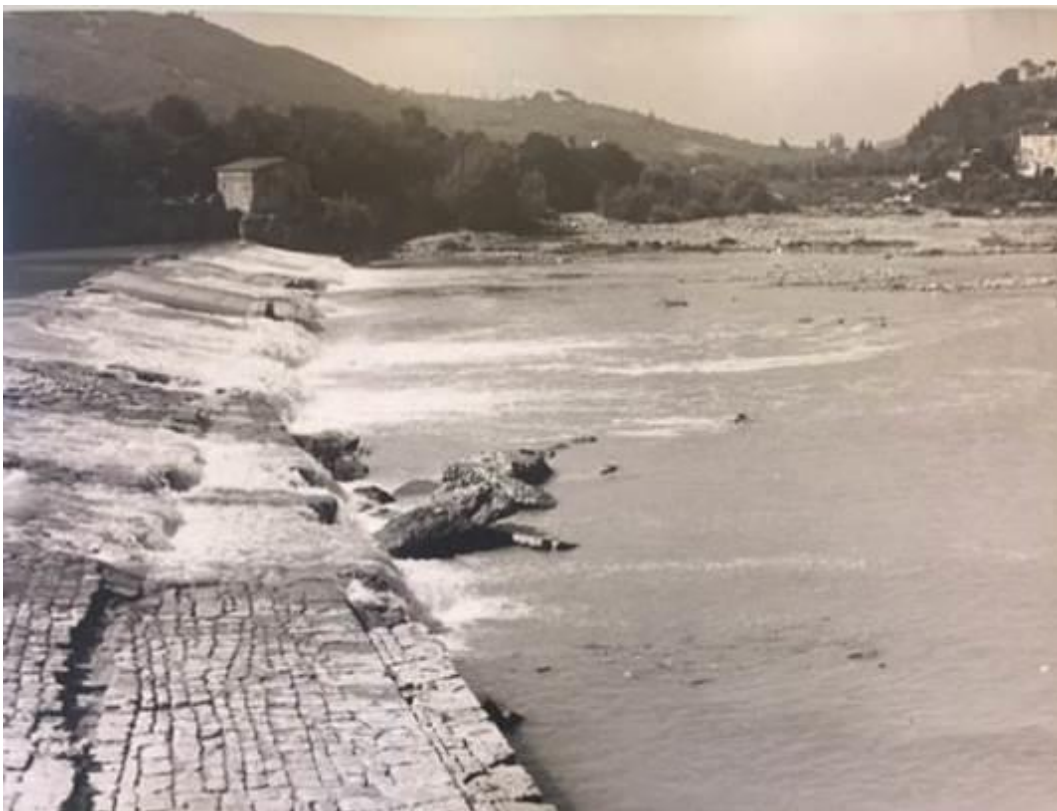
Figura 2.19 - Cartolina illustrata in b/n tratta dalla Collezione Carlo Benvenuti che ritrae la pescaia di Sieci intorno agli anni '50 del XX secolo. Da notare la presenza del dorso della briglia ancora intatto costituito da blocchi di pietra locale disposti in filari regolari, a differenza degli attuali blocchi di cemento e pietra sulla parte bassa della briglia, ben evidenti nell'immagine attuale della pescaia.
