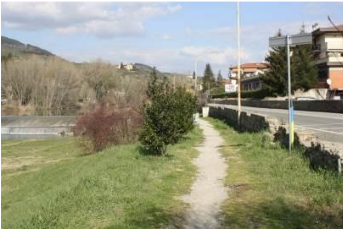
Figura 2.30 - Percorso pedonale esistente. Siepe di allori da integrare, muro in pietra da ripristinare e percorso da riqualificare
