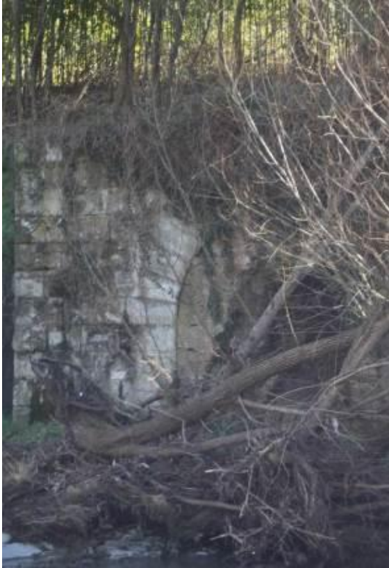
Figura 2.43 - Particolare del canale di scolo della briglia con arco in pietra da ripulire e riportare alla luce nella sua interezza
