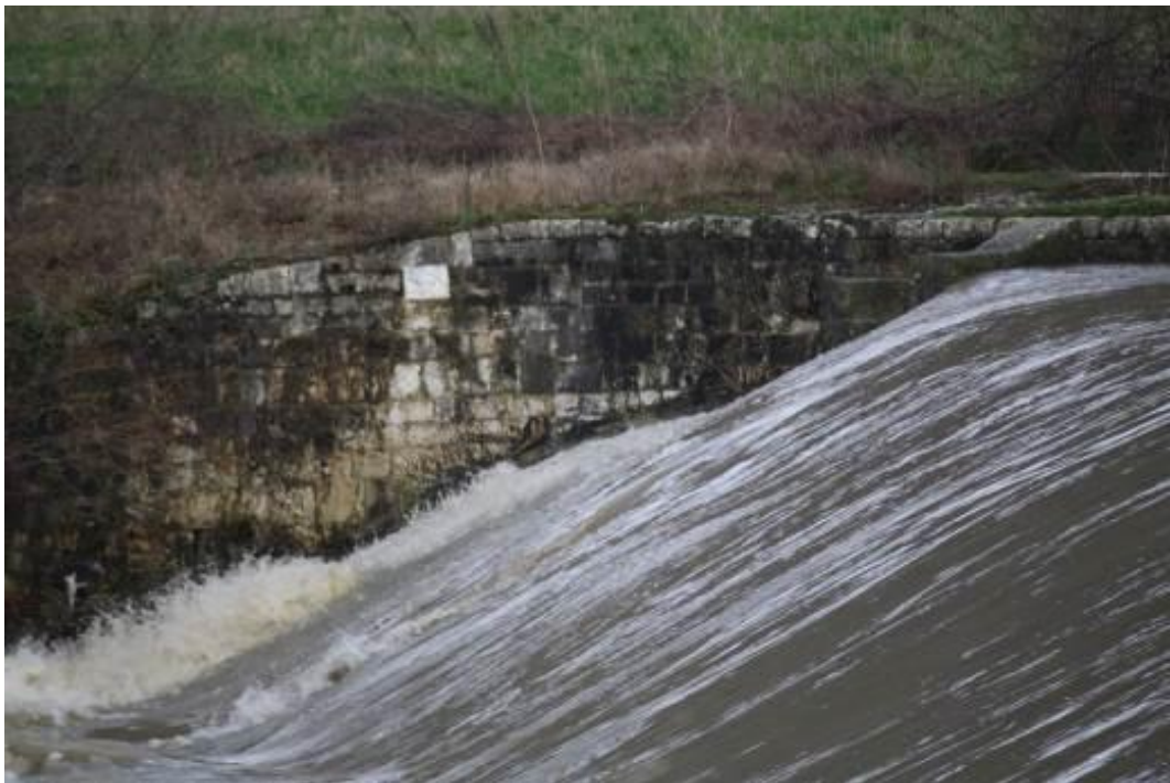
Figura 2.13 - Pescaia a Rufina (Firenze), località. Masseto e particolare del muro a fianco della pescaia, in bozze squadrate
