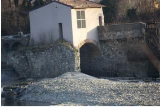
Figura 2.20 - Particolare dello scarico di gora della pescaia di Sieci e della muratura in pietra locale presente
