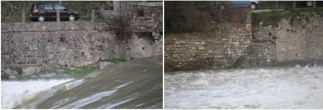
Figura 2.29 - Particolari del muro in destra idraulica del fiume Sieve alla pescaia di San Francesco, realizzato in bozze squadrate di pietra locale
