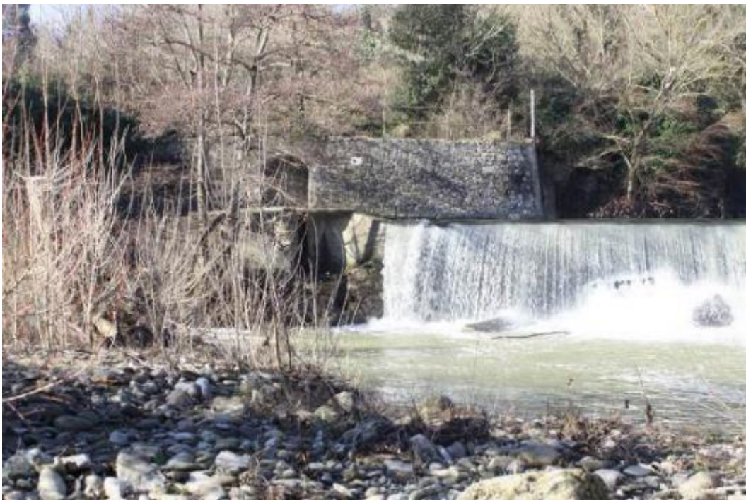
Figura 2.12 - Pescaia a Rufina (Firenze), località Alessandri. È visibile in sponda idraulica destra del fiume la vecchia gora ancora intatta, con il paramento murario in pietra locale con colorazione grigio scuro.
