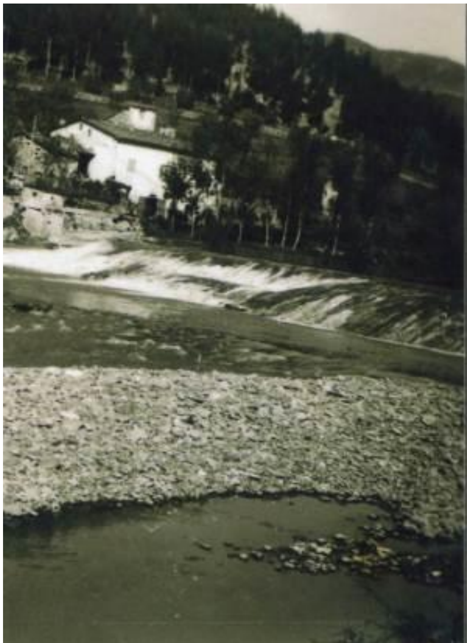
Figura 2.27 - Veduta della pescaia di San Francesco. La pescaia aveva forma più regolare ed un solo salto di quota, rispetto ai due odierni.
